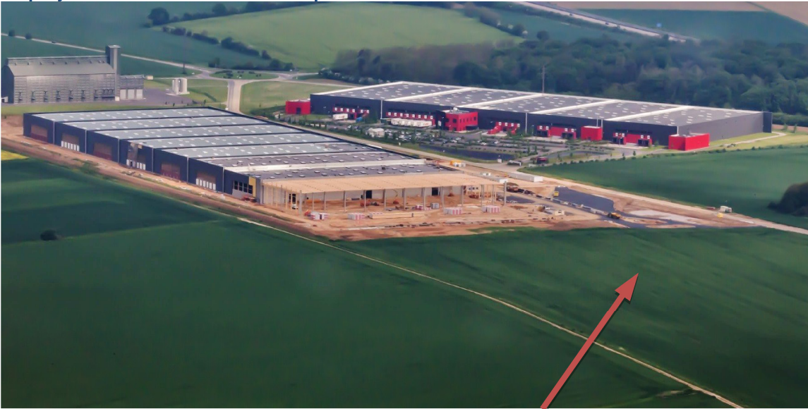
Photo du site en construction et vue de la parcelle d'implantation de l'extension
